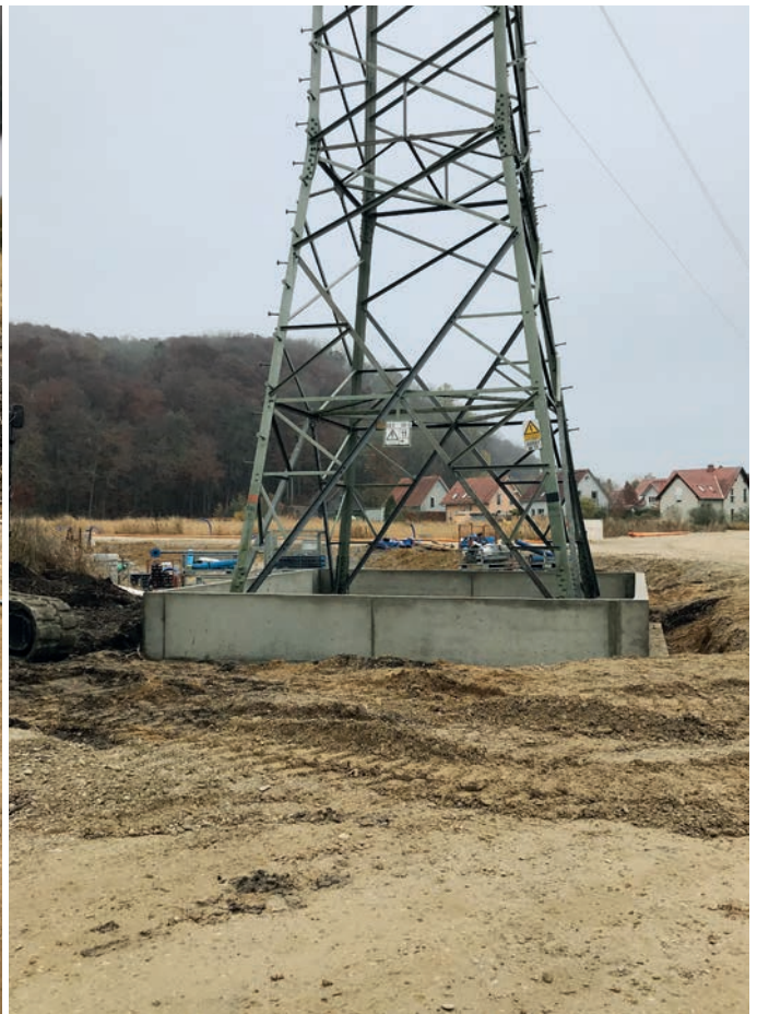
Links: Erschließungsarbeiten Straße, rechts: Hochspannungsmast Umwehrung mit Betonscheiben zur Verkehrssicherung
