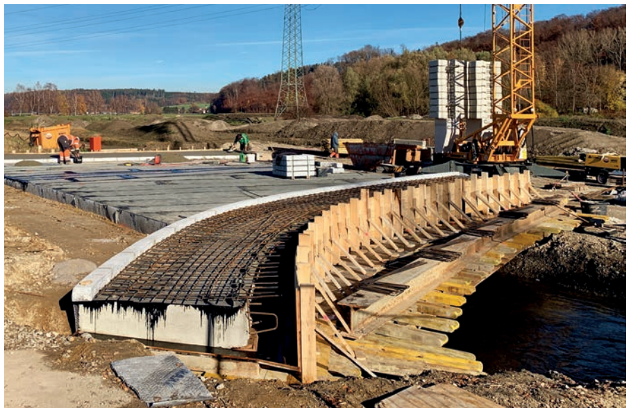
Brückenneubau an der St 2381 über die Friedberger Ach zum neuen Baugebiet
