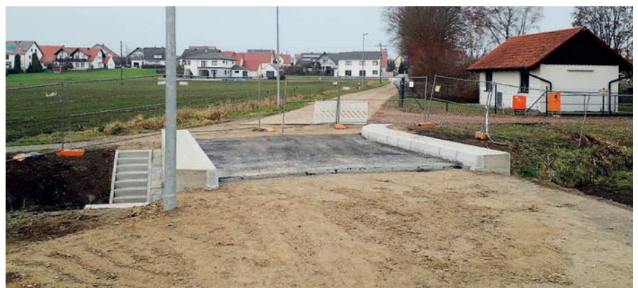
Brücke Gebenhofen, Schmiedbergweg
