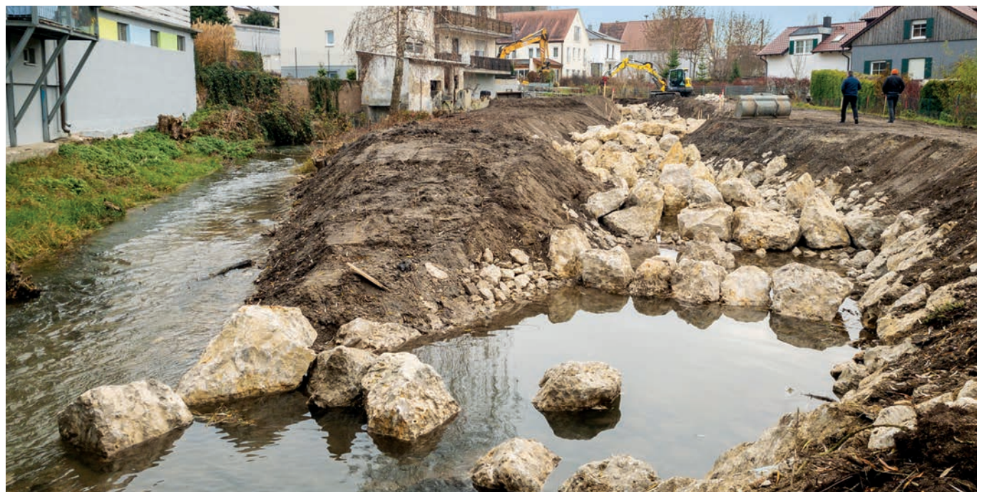
Blick auf das Areal der alten Säge; links der noch zu verfüllende alte Bachverlauf, rechts das neue naturnahe Bachbett
