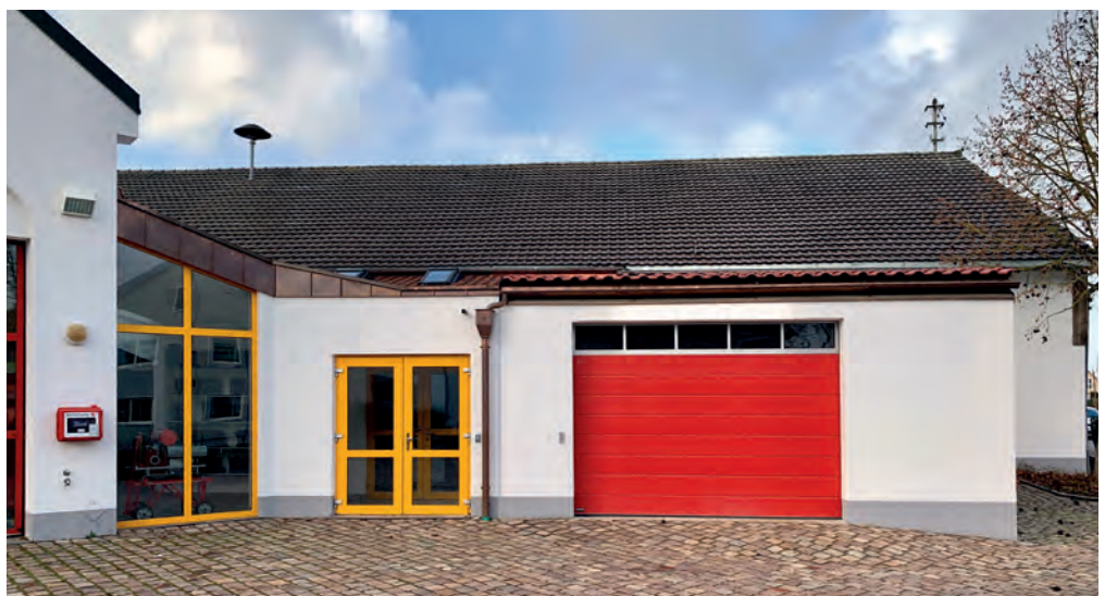
Anbau Freiwillige Feuerwehr Haunschwies
