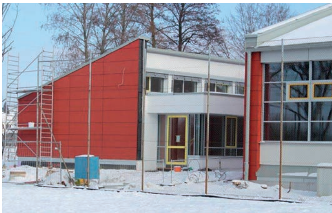
Anbau Grundschule Affing
