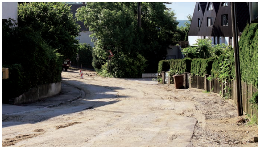
Ortsdurchfahrt Bergen – Derchinger Straße
