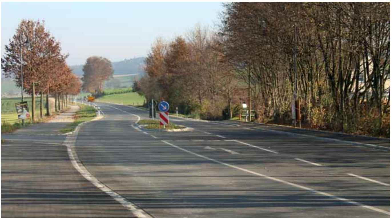
Querungshilfe mit Abbiegespur in Bergen
