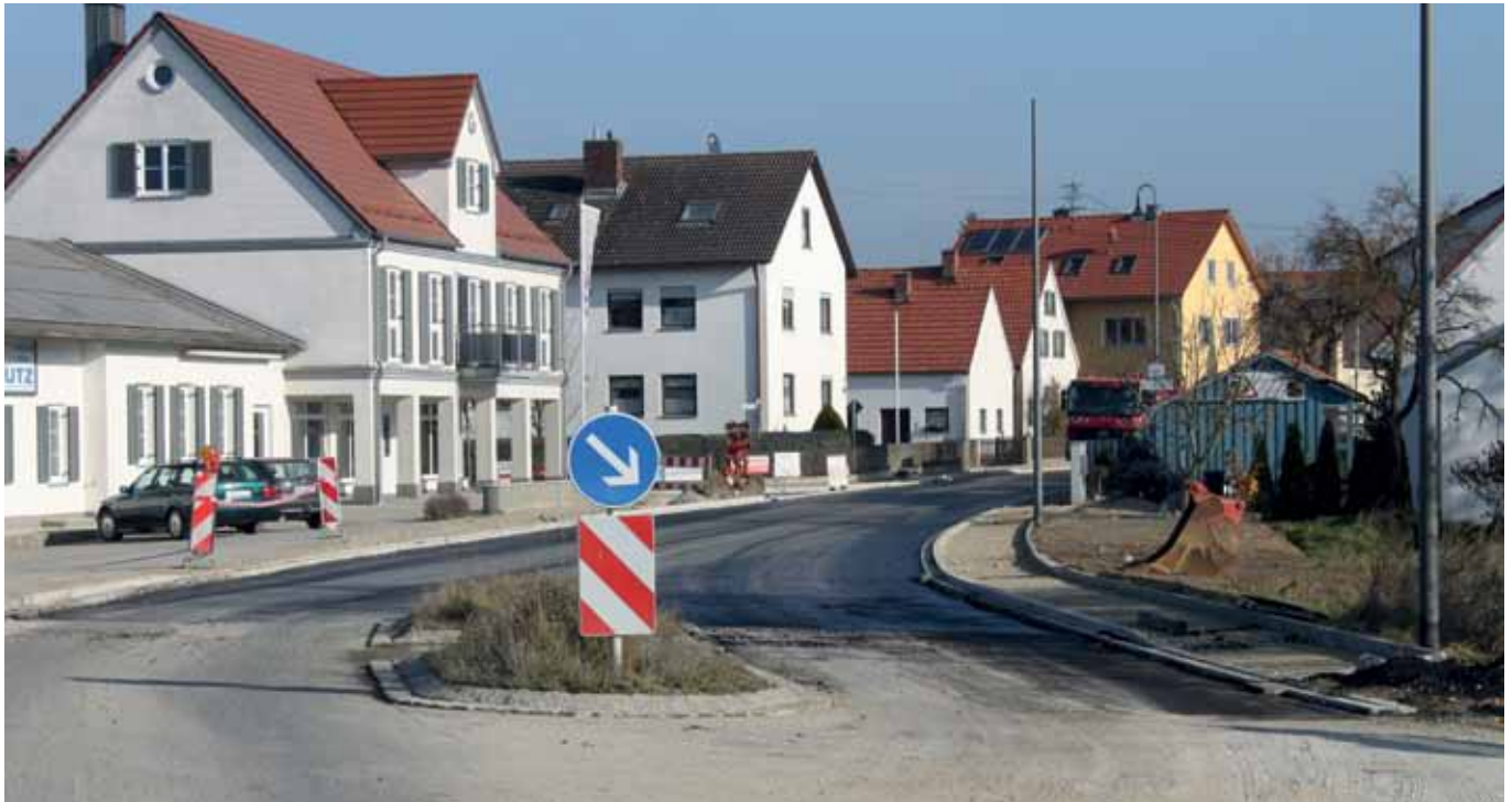
So weit ist die Ortsdurchfahrt Aulzhausen Ende November 2011
