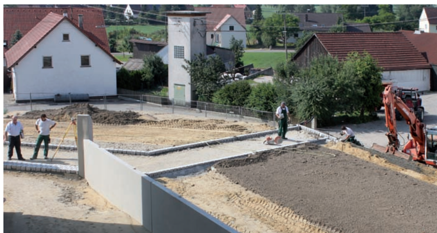
Momentaner Stand der Bauarbeiten des Friedhofs in Gebenhofen
