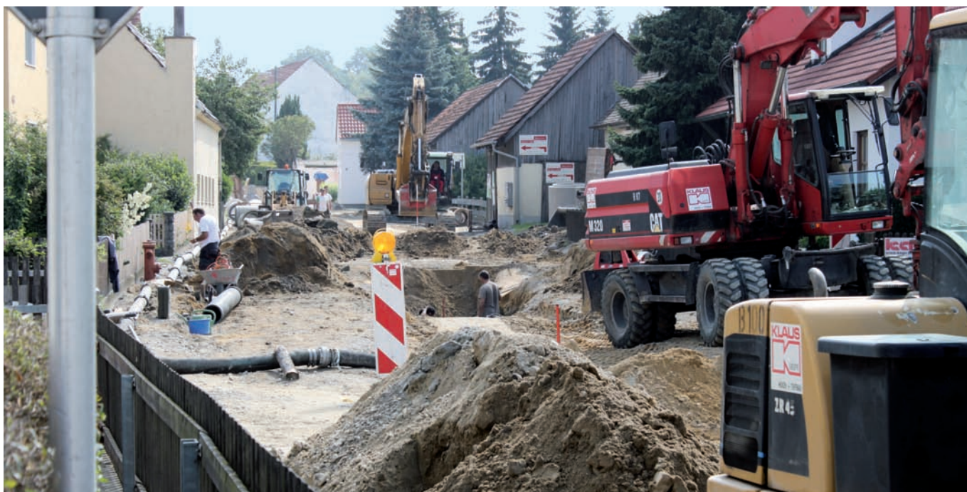
Die Arbeiten zur Erneuerung des Mischwasserkanals mit den Hausanschlüssen und Wasserleitungsanschlüssen
